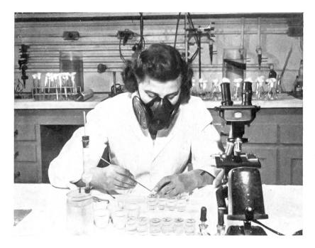
"Carbon 14", radioaktiver Kohlenstoff, der für wissenschaftliche und medizinische Forschungszwecke große Bedeutung bekommen hat, wird hier — nach Anwendung besonderer Schutzvorrichtungen für die ausführenden Wissenschaftler — in Bakterienkulturen eingeführt
