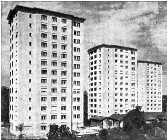
Abb. 6. Die Hochhäuser in Basel
