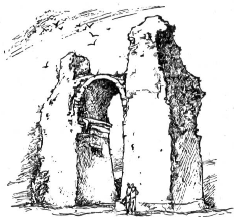
Abb. 1. Das „Heidentor“ bei Petronell mit seinem 6 m weit gespannten Ziegel-Gewölbebogen zwischen zwei massigen Türmen ist nur einer der vielen antiken Ziegelbauten, die Jahrtausende überdauerten
