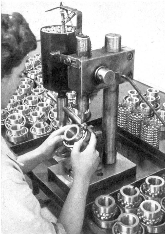
Einfüllen der Kugeln in Pendelkugellager
