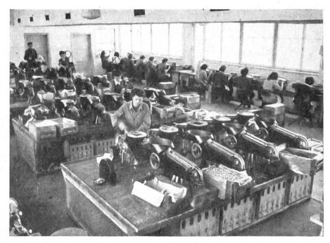
Nach vielen Kontrollen, Egalisieren und Polieren werden die Kugeln dann automatisch gemessen und sortiert. Das Bild zeigt die automatischen Sortiermaschinen
