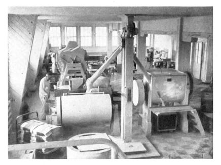
In aller Welt werden heute Mischungen aus einem Säureträger und Natrium-Bikarbonat als "Backhilfen" und "Backpulver" verwendet. Die Bestandteile müssen innig vermischt werden, wobei noch ein sogenanntes "Trennmittel" beigefügt wird. Das Bild zeigt einen Blick in eine solche Mischerei
