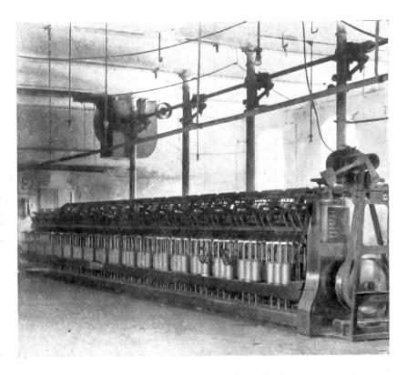
s pinnmaschine (Abb. 3) eine schwache Drehung, die lediglich den Zweck verfolgt, dem feinen Bändchen genügend Halt zu geben, um es der Feinspinnmaschine vorzulegen. Das gedrehte Bändchen oder Vorgarn wird auf Spulen gewickelt, die am Vorgarngerüst der Feinspinnmaschine aufgesteckt werden.
