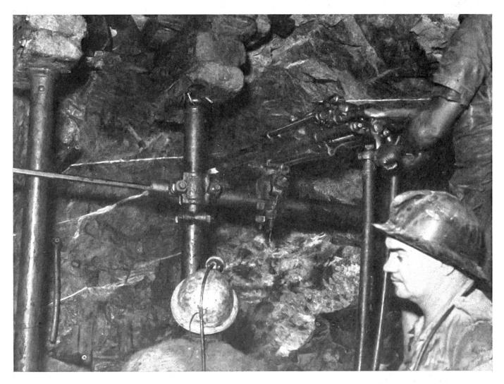
In Witwatersrand in Südafrika ist die größte Goldindustrie der Welt entstanden. Die Goldminen liegen hier sehr tief, zum Teil bis zu 3000 m unter der Erdoberfläche. Das Bild zeigt Minenarbeiter einer Goldgrube beim Ausbohren von Sprenglöchern
