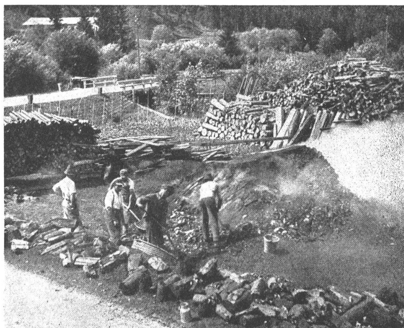
Abb. 1. Ein Kohlenmeiler im österreichischen Alpenland brennt ab. Im Vordergrund sieht man die gewonnenen Holzkohlenstrünke
