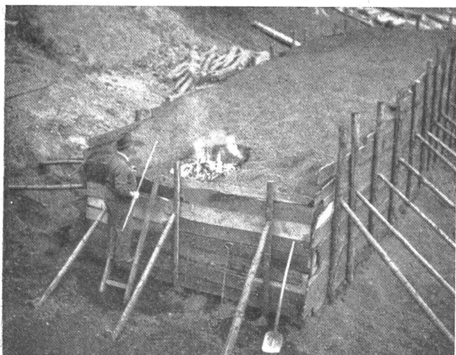
Abb. 3. Nachdem der Haufen „schwarzgemacht“ worden ist, wird er angezündet. Nach einigen Stunden wird die Öffnung mit Reisig und Lösch sorgfältig abgedichtet; die Verkohlung beginnt. Deutlich sind die Luftlöcher zu sehen (unten)
