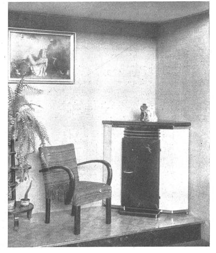
Abb. 1. Eine Neukonstruktion, der "Wiener Kamin" mit Allesbrenner-Dauerbrandeinsatz und beiderseits eingebauten Sturzzügen, die eine rationelle Ausnutzung der Brennstoffe gewährleisten
