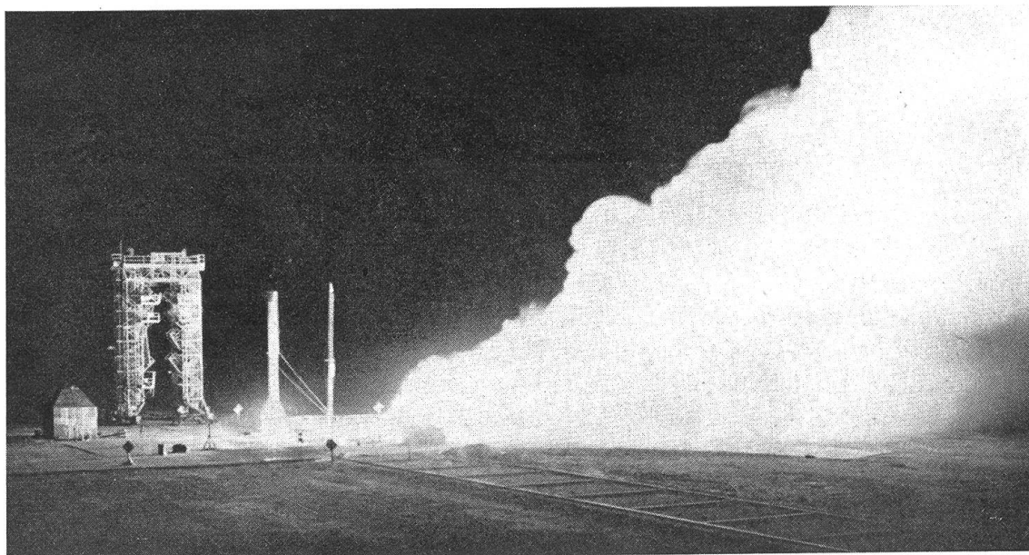
Letzte Prüfung einer „Viking“ in der Nacht vor dem Start. Die Rakete ist dabei fest auf dem Starttisch verschraubt. Der Gasstrahl tritt in einen wassergefüllten Schacht und beleuchtet die entstehenden Dampfschwaden.
