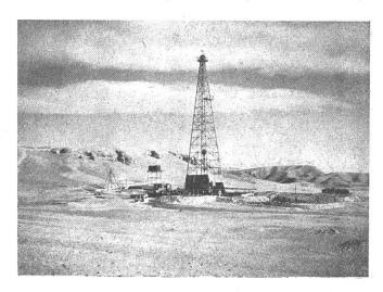
Mit Hilfe eines 35 m hohen Bohrturms wird bei Guerrara Wasser erbohrt
