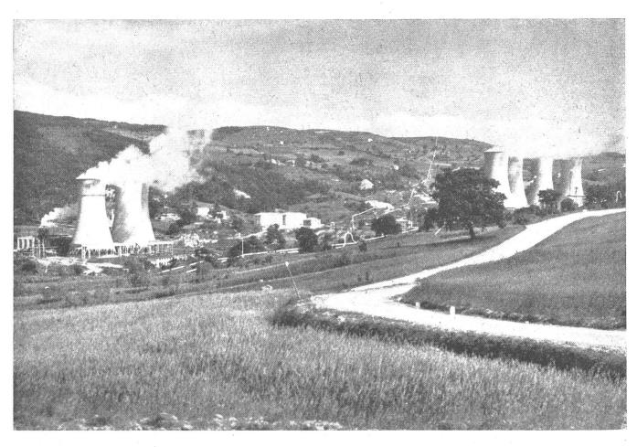
als Charakteristikum die riesigen Kühltürme aufragen, in denen der Dampf zu Wasser kondensiert wird. Da es in dieser Gegend an Wasser mangelt, muß der reine Dampf für die indirekte Methode der Energiegewinnung aus Kondenswasser erzeugt werden. Außerdem scheidet man aus ihm die chemischen Produkte ab
