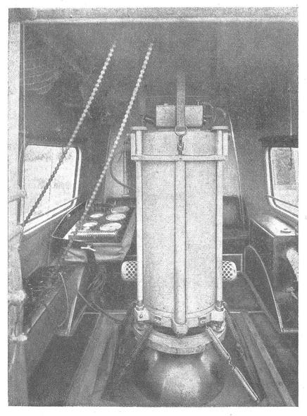
Ein Schweremeßgerät, in einem <sup>der</sup> Forschungsautos montiert
