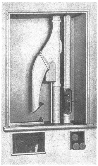
Abb. 2. Die vom Absender durch einen Knopfdruck gesteuerte Weiche bedeutete den ersten Schritt zur Automatisierung des Rohrpostbetriebes. Links das Empfangsrohr mit Weichenausschleusung, rechts das Senderohr. Die Druckknopftafel befindet sich außerhalb des Bildes an der Wand
