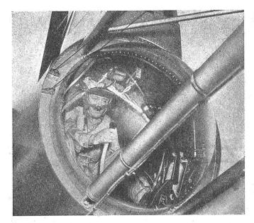
Abb. 4. Der Tankwart im Heck des Tankers leitet mit dem Steuerknüppel die Bewegung des "Flying Boom" (Luftfahrt-Archiv Herwig)
