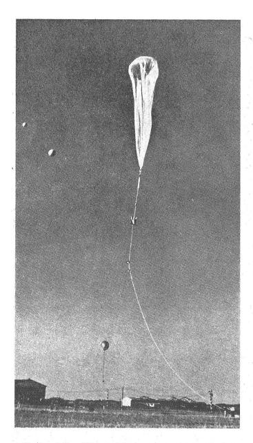
Beim Start ist die Ballonhülle des Skyhook wie die aller derartigen Höhenballone relativ schlapp. Mit zunehmen der Steighöhe dehnt sich das Füllgas aus, bis die Hülle am Kulminationspunkt straff gespannt ist
