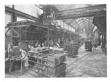
Abb. 5. Teilansicht der Pressenhalle. Die auf Brennwagen gesetzten Steine gelangen zur Trocknung in einen Trockenofen und werden anschlieβend in Tunnelöfen gebrannt
