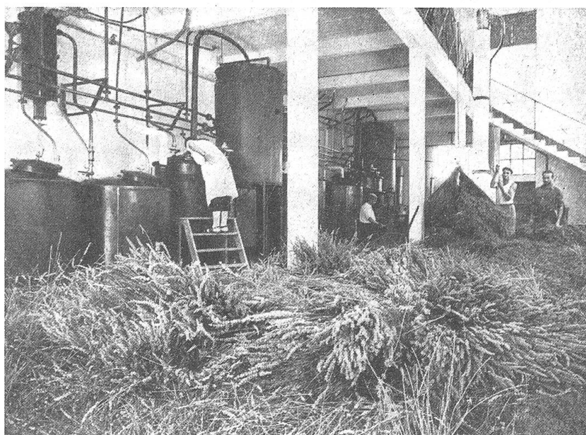
Abb. 3. Der Extraktionsraum einer Parfümessenzfabrik in Grasse, wo so-genannte „concrètes“ durch flüssige Lösungsmittel, wie Aetherpetrol oder Ben-zin, gewonnen werden. Die am Boden bereitliegenden Pflanzen sind Lavendel
