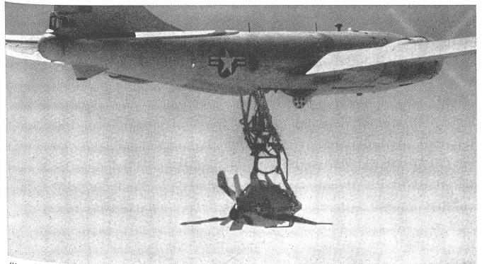
Abb. 1. Die Superfestung Boeing B-29 hat das "Trapez" mit dem daranhängenden Parasiten-Flugzeug ausgehahren. Die Flügel des kleinen Jägers sind aufgeklappt. Der Pilot braucht nur noch das Zeichen zum Ausklinken um selbständig weiterfliegen zu können. Der Antrieb des Parasiten erfolgt durch ein Düsenaggregat; über seine Schnelligkeit und Steigfähigkeit ist vorläufig noch nichts bekanntgeworden
