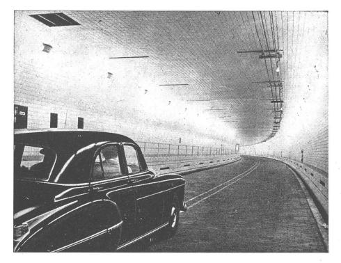
Abb. 4. Cremefarben gekachelt sin Decke und Seitenwände, blendfin beleuchtet die Fahrbahn, erst m abnehmender, dann wieder mit z nehmender Lichtstärke. Links de Laufsteg mit einer Fernsprechstell für die Wachtposten
