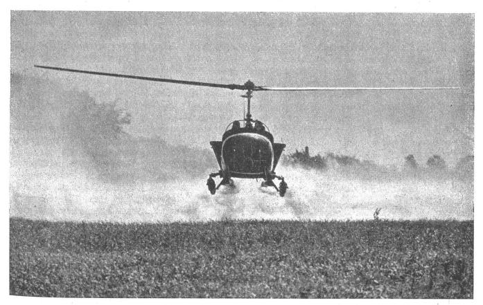
Ein Hubschrauber vom verbesserten Typ 47-C der Aircraft Comp. bei der Schädlingsbekämpfung, wozu sich Hubschrauber besser als jeder andere Flugzeugtyp eignen, weil der von den Windmühlenflügeln erzeugte Abwind das pulverige Schädlingsbekämpfungsmittel nach unten drückt
