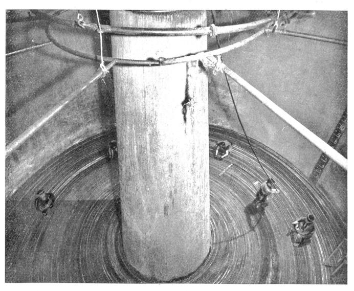
Abb. 6. Die Einschiffung des Kabels in den Kabeltank des Schiffes erfordert größte Exaktheit und dauert oft Wochen. Das genaue Einlegen des Kabels sichert auch ein störungsfreies Ablaufen bei der Verlegung
