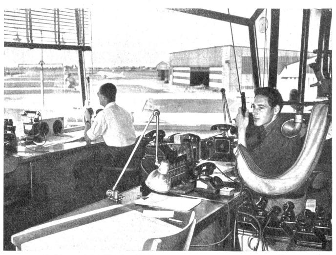
Abb. 5. Die Flugleitung auf dem Flugplatz. Von hier aus werden die Flugzeuge im Anflug, während Landung und Start sowie im Abflug geleitet
