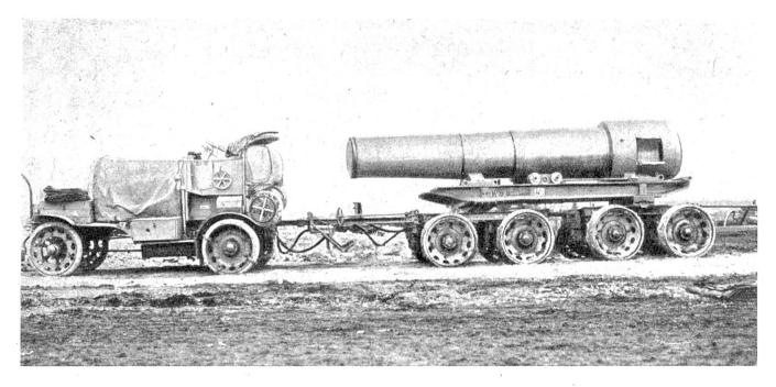
Abb. 4. Die berühmteste und großartigste Durchbildung des "Electro-mixte"-Systems im Kraftfahrzeugbau bildeten die sogenannten "C-Züge" von Austro-Daimler, die in der k. u. k. österreichisch-ungarischen Armee zum Transport der schweren Belagerungsgeschütze von 24 bis 42 cm Kaliber verwendet wurden. Dargestellt ist hier der Rohrwagen einer 38-cm-Haubitze, links der Generatorwagen
