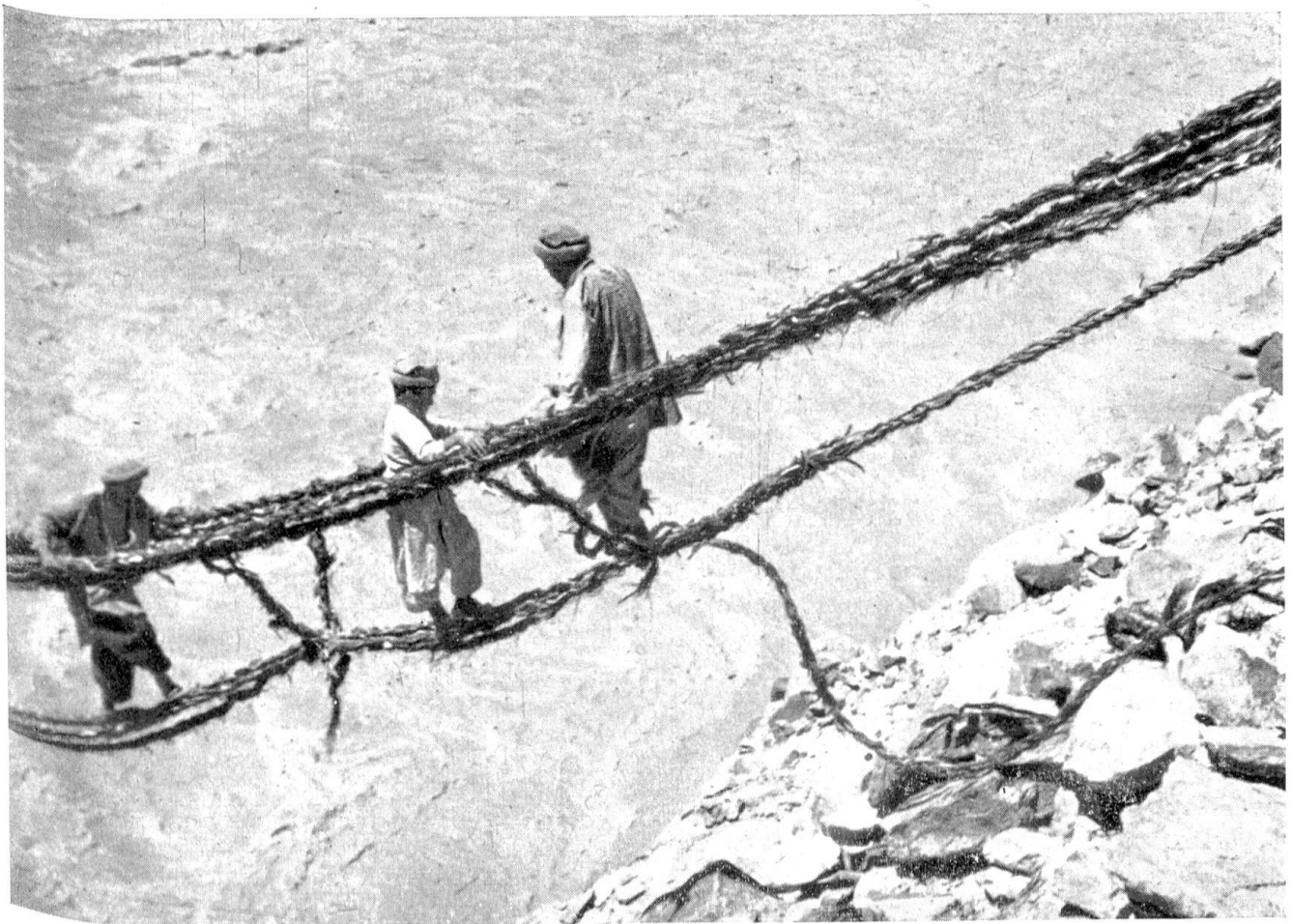
Eine aus Weidenästen konstruierte Seilbrücke ermöglicht den Flußübergang
