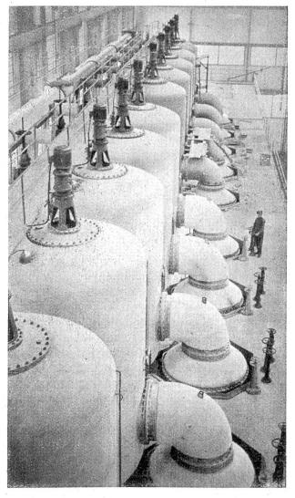
Von Escher Wyss AG, Zürich, für Eindampfzwecke gebaute größte Wärmepumpenanlage der Welt mit zwanzig Verdampfern und fünf Turbokompressoren für eine stündliche Wasserverdampfung von 100 Tonnen
