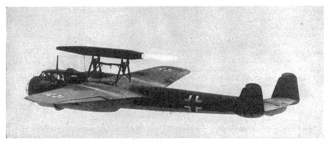
Staustrahlrohr, zu Versuchszwecken auf ein Dornier-Flugzeug als "fliegender Prüfstund" aufgebaut. Durchmesser 1,5 Meter, Länge 10,6 Meter
