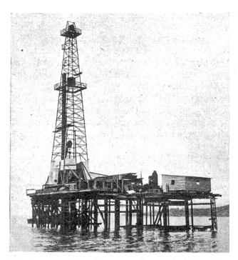
Eine etwa einen Kilometer von der Küste entfernt errtchtete "eiserne Insel" mit Bohrmaschinerie zur Ölgewinnung aus dem Pazifischen Ozean
