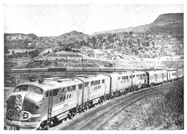
Vier aneinandergekoppelte Diesel-Motor-Einheiten bilden die Lokomotive dieses aus fünfzehn Personenwagen bestehenden Expreßzuges in einer großen Kurve kurz vor der Höhe des Raton-Passes in Neu-Mexiko
