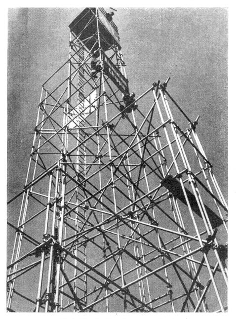
Abb. 1: Ein Hochbau-Gerüst aus Aluminium
