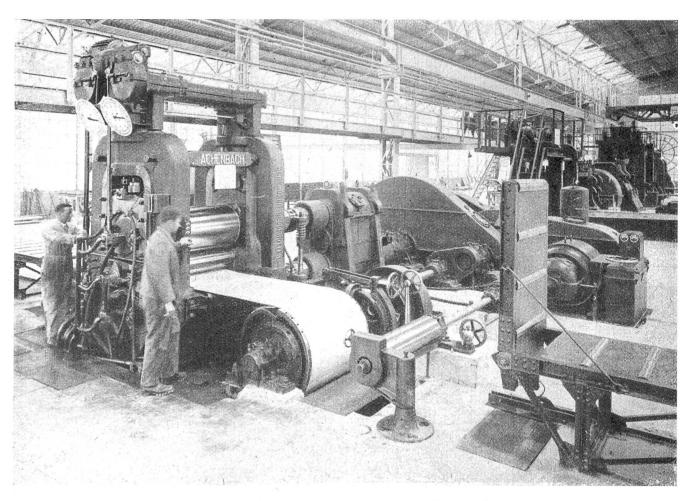
Abb. 3: Aluminium-Bandwalzwerk
