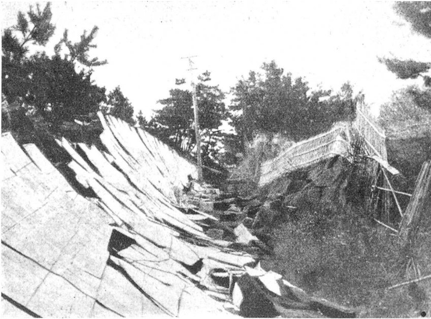
In eine Spalte versunkene Autostraße an der Sagami-Bucht auf Hondo nach einem Beben von 1923
