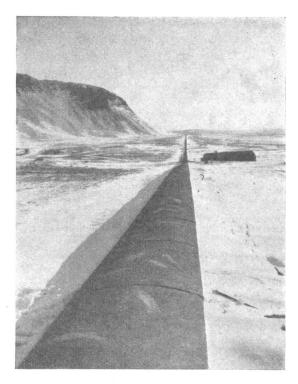
Bild 2: Die Leitung im Betrieb im Winter. Sie zieht sich 20 km lang in schnurgerader Führung durch die Weite der isländischen Landschaft. Die Betondeckel des Rohrkanals werden so warm, daß sich keine Schneedecke darauf bilden kann.
