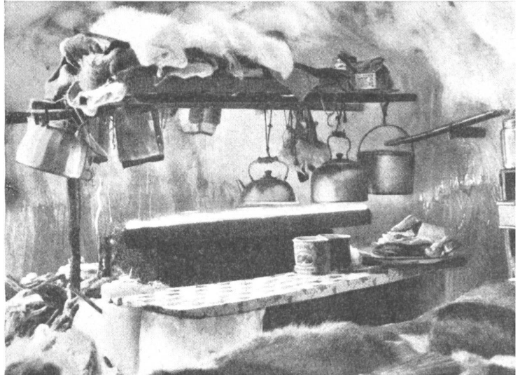
Bild 7: Eingang und Fenster im Innern eines Igloo. Das Fenster ist aus durchsichtigem Eis gemacht, das ein- bis zweimal im Tage vom Rauhreif befreit werden muß. Die untere Öffnung ist die Türe, die zu einem kleineren Schneehaus führt, das als Vorratskammer dient.
