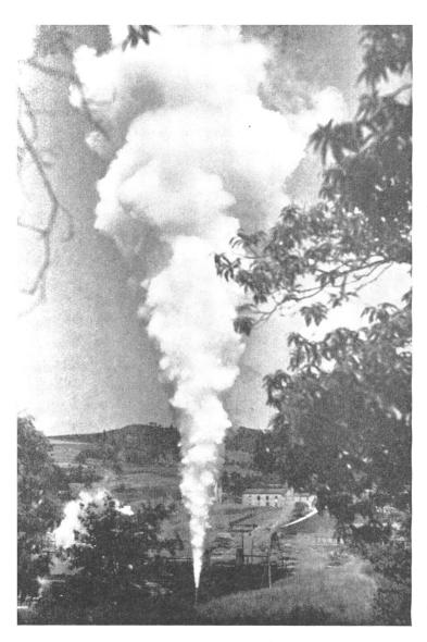
Bild 2: Freier Dampfaustritt aus einer der ersten Tiefbohrungen.
