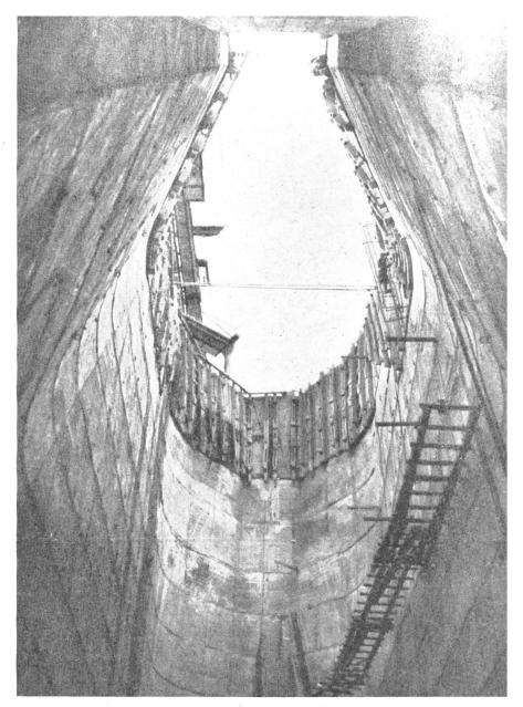
Bild 1: Einer der Mauerhohlräume von innen. Wie in einem Dom kommt sich der Beschauer vor, wenn er den Blick vom Grunde zur oberen Verschalungsfläche richtet.
