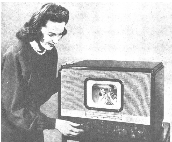
Bild 24: Kleines amerikanisches Tischmodell mit einer Fernsehröhre von 17\frac{1}{2} cm Durchmesser. Die Bilder sind so hell, daß sie in normal beleuchteten Räumen betrachtet werden können.
