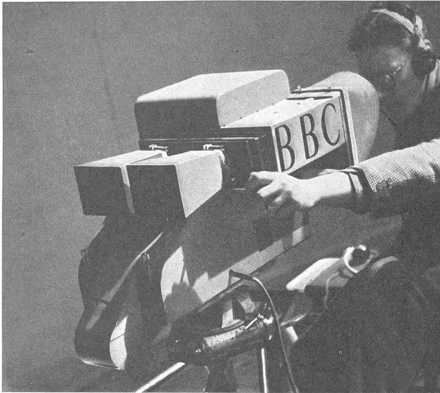
Bild 3: Die nach dem Prinzip des Ikonoskops konstruierte Emitron-Kamera der BBC. Die Kamera arbeitet vollkommen lautlos, damit störende Geräusche während der Sendung vermieden werden. Auf einem Gestell mit pneumatikbereiften Rädern läßt sie sich durch das Studio fahren, um während der Sendung den Ort zu wechseln. Die Bedienungs-mannschaft ist durch Kopfhörer mit dem Kontrollraum in ständiger Verbindung, von wo sie ihre Weisungen erhält.
