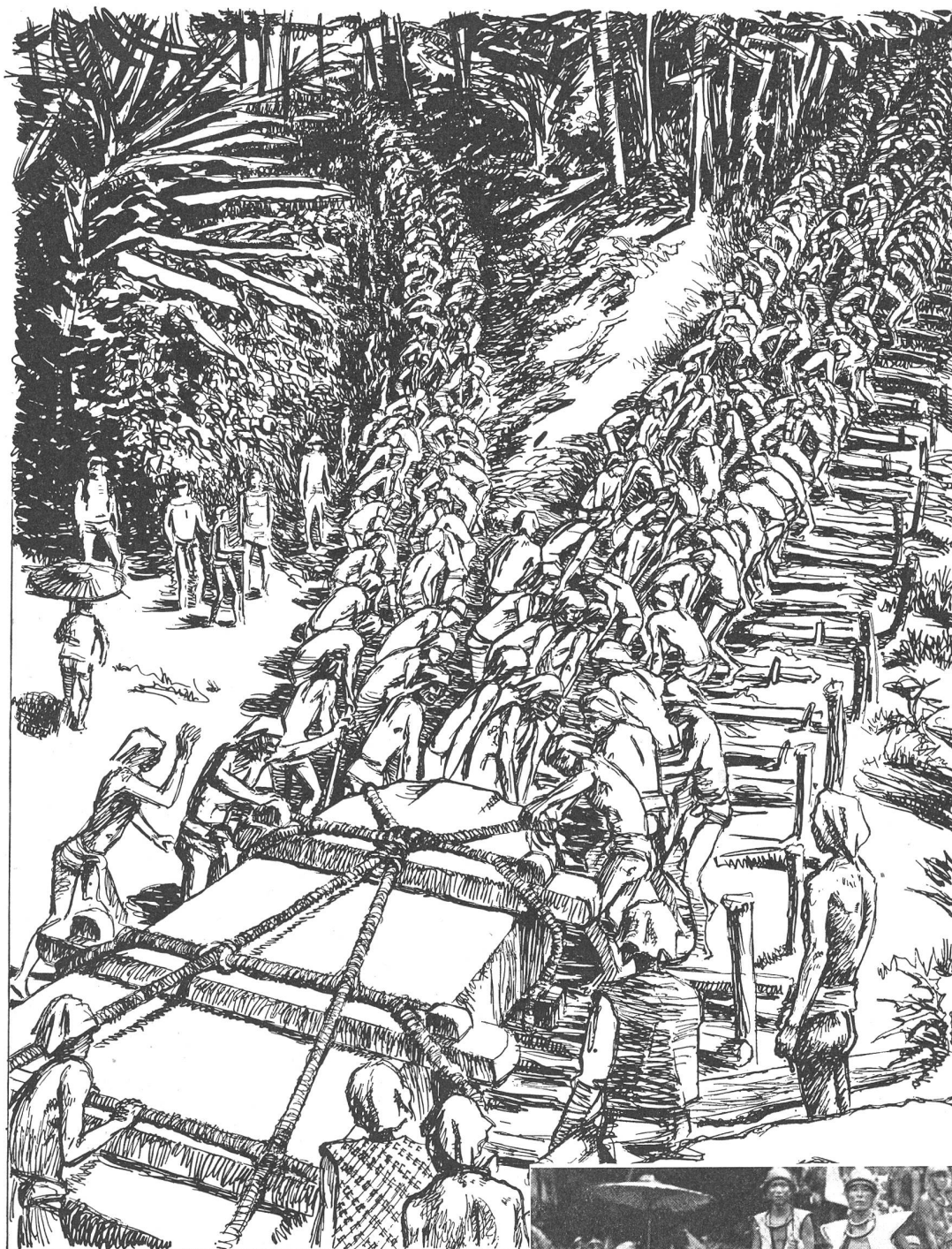
Bild 8 und 9: Transport einer großen Grabplatte auf der Insel Nias in Indonesien. Das Bild wurde nach einer Photographie von G. Schröder aus der Kollektion des Indischen Institutes in Amsterdam gezeichnet. 525 Mann sind daran eine 300 Meter hohe Steigung zu überwinden. Für den ganzen Weg von drei Kilometern brauchten die Leute zwei volle Tage.
