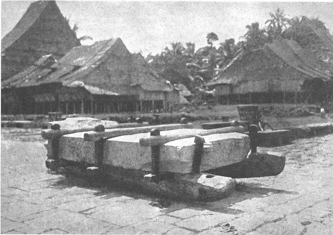
Bild 7: Hölzerner Schleppschlitten mit großer Steinplatte auf der Insel Nias (Indonesien). Photo G. Schröder
