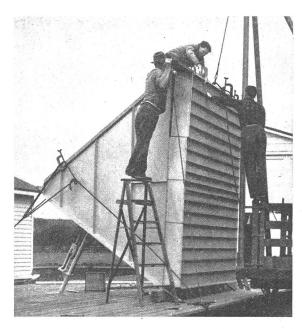
Bild 7: Aufstellung des ersten großen Modells einer Radiolinsenantenne.
