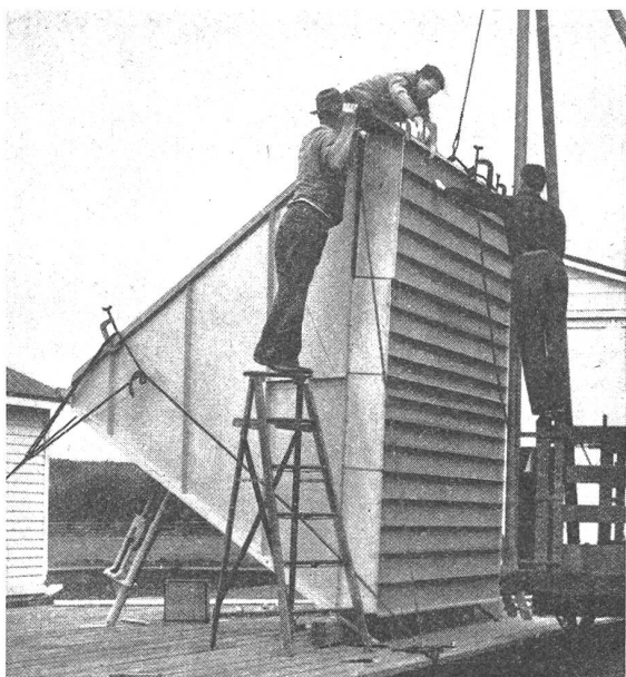
Bild 7: Aufstellung des ersten großen Modells einer Radio-linsenantenne.
