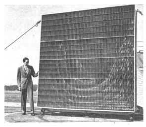
Bild 5: Eine der acht Zwischenantennen des New York-Boston-Radiorelaissystems, das hauptsächlich für Fernsehübertragungen zwischen den beiden Städten dienen wird.
