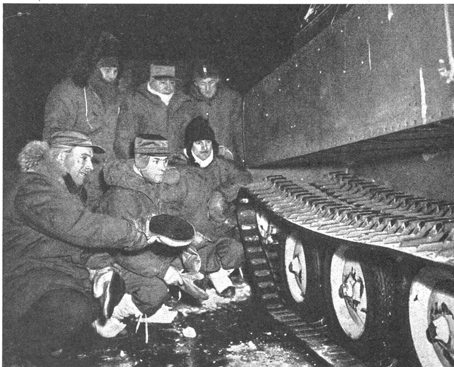
Wie sorgfältig die technische Vorbereitung war, beweist das Bild, welches die Konstruktion der Raupenbänder und der darauf aufgenieteten Schneegreifer zeigt. Die beiden nebeneinander angeordneten Raupenbänder und die darauf befindlichen nicht überall gleich hohen Metallgreifer, die auch noch einen Gummigleitschutz erhielten, machten ein Rutschen unmöglich. Russische, chilenische, peruanische und amerikanische Militärattachés lassen sich vom Führer der Expedition die Details des Raupenantriebs erklären.
