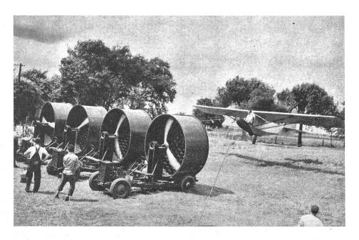
Bild 8: Segelflug an Ort. Im Staate Illinois in den Vereinigten Staaten macht man sogar den Wind selbst. Der künstliche Propellerwind ist derart stark, daß ein Schulgleiter, gefesselt an zwei Seilen, «an Ort» schweben kann.
