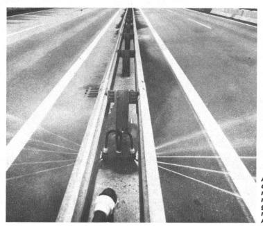
Abb. 2. Sprühdüsen der automatischen Taumittelsprühanlage auf dem Flamatter Viadukt in Aktion
