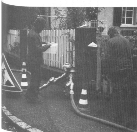
Kurzzeitige Hydrantenentnahme.
