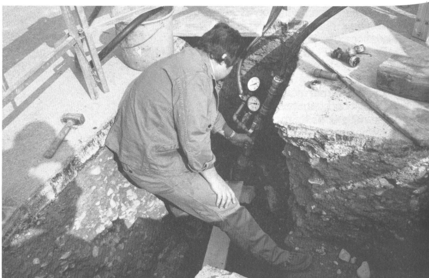
Sanierung einer 70jährigen Gasleitung mit Penetrol: mit wenig Aufwand wieder vollwertig.
