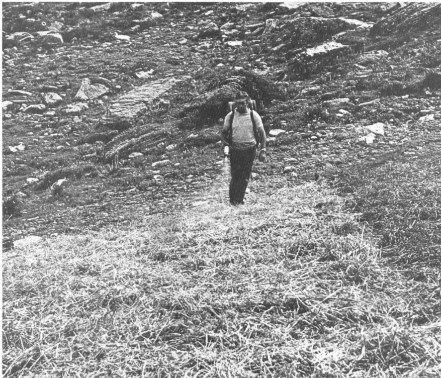
Für das Ausbringen von Klebern eignen sich Motorrückenspritzen sehr gut. In den Versuchen hat sich zum Beispiel der Typ Microniseur SP71 (Fa. Birchmeier) als ein äusserst problemloses Gerät herausgestellt. Rechts: Strohdecksaat mit Bitumen. Links: Die helle Fläche (Stroh) wird mit einem Prototyp von Lonzafix alpin verklebt.
