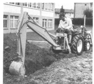
Arbeiten mit dem vollhydraulischen Heckbagger
