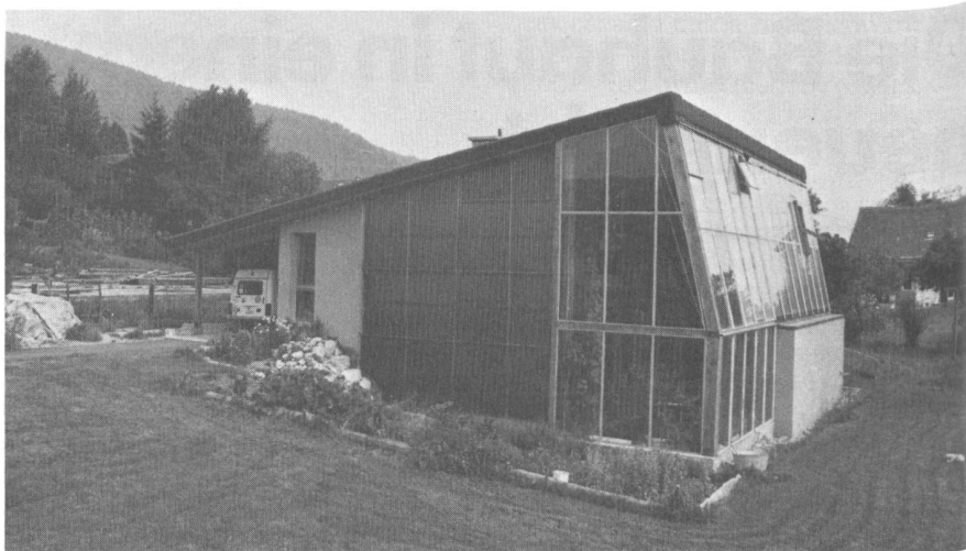
EFH-Experimentierhaus Les Geneveys-sur-Coffrane, VWS 10 cm, 1979, Barbier, Baugeschäft, Boudevilliers.
