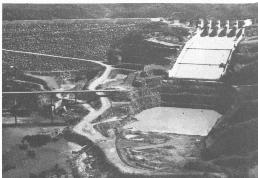
Die Mehrzweckanlage Pedra do Cavalo dient in erster Linie der Trinkwasserversorgung der Stadt Salvador do Bahia in Brasilien. Links der fast vollendete 140 m hohe Steindamm und rechts die Hochwasserentlastung mit den deutlich erkennbaren Belüftungsabsätzen zur Verhinderung von Schäden durch Kavitationserosion.
