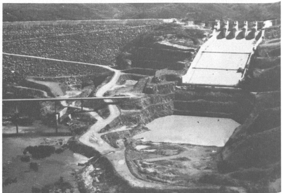
Die Mehrzweckanlage Pedra do Cavallo dient in erster Linie der Trinkwasserversorgung der Stadt Salvador do Bahia in Brasilien. Links der fast vollendete 140 m hohe Steindamm und rechts die Hochwasserentlastung mit den deutlich erkennbaren Belüftungsabsätzen zur Verhinderung von Schäden durch Kavitationserosion.
