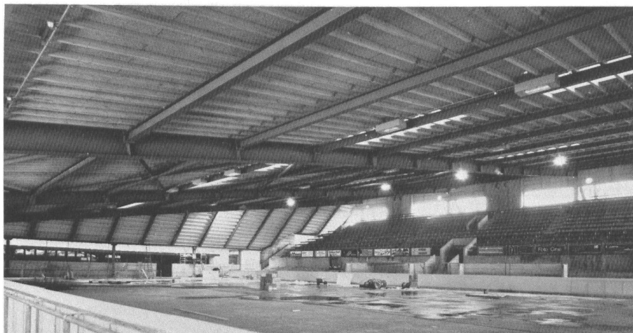
Kunsteisbahn Dübendorf. 3900 m 2 Schichtex-Spezial 125/III, Format 200×64 cm, mit allseitigem Falz, Sichtseite mit Strukturanstrich gelb.
