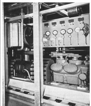
Abb. 4. Der Total-Energie-Anlage-Block in der neuen Heizzentrale: links der Generator/Elektromotor, rechts der Kompressor der Wärmepumpe.
