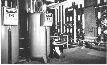
Abb. 5. Hinter dem TEA-Block in der Heizzentrale: rechts die Wärmeverteilanlage, links ein Heizwasserspeicher und rechts daneben der Drucker der Mikroprozessorsteuerung.
