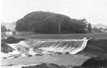
Abb. 8. Blick vom Waaghaus bei der Einfahrt in die Deponie (siehe auch Abb. 9) auf die in Ausführung befindliche Abdichtung mit KDB Sarnafil Paus HDPE (Bauzustand Mitte August 1981).
