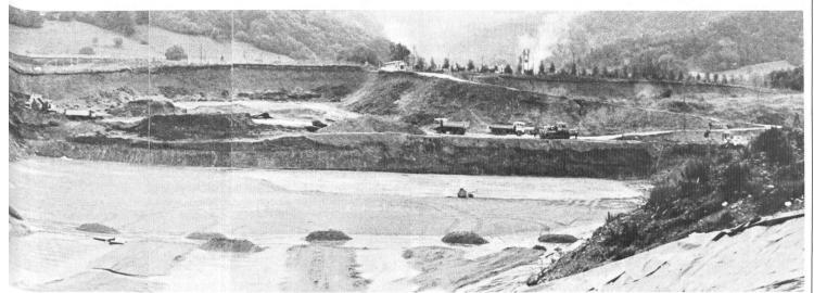
Weisser Streifen) verlegt. Im Mittelgrund Sandhaufen und -lagen zur Beschwerung der verlegten Abdichtung. Anschliessend wird der Sand in der Stärke von ¹0 cm als Schutzschicht gegen Beschädigung (Durchstossen) ausgebreitet. Im Hintergrund noch Tiefbau-(Aushub-)Arbeiten (Bagger und Transportfahr≥euge). In Bildmitte hinten das Waaghaus = Standort der Aufnahmen der Abbildungen 1 und 9. Zeit der Aufnahme: Mitte August 1981.
