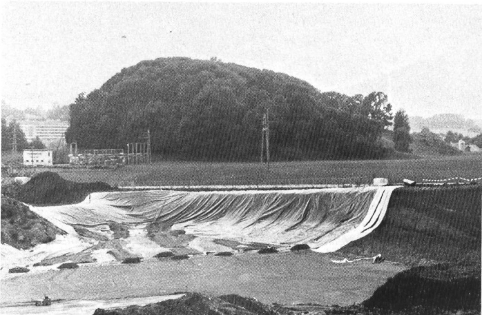
Abb. 8. Blick vom Waaghaus bei der Einfahrt in die Deponie (siehe auch Abb. 9) auf die in Ausführung befindliche Abdichtung mit KDB Sarnafil P aus HDPE (Bauzustand Mitte August 1981).
