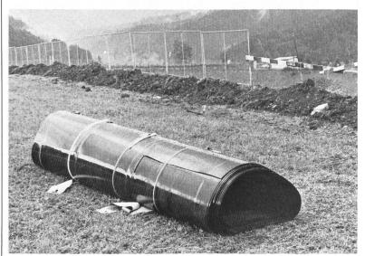
Abb. 5. Bereitgelegte Rollen Sarnafil P 2 mm stark aus HDP. Für das Ablassen der KDB vom Böschungsrand nach unten werden werkseitig Bänder eingerollt.
