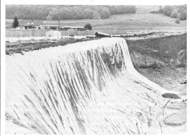
Abb. 10. Blick von Westen auf die gesicherte Deponie Châtel-St-Denis. Im Vordergrund verlegte 2 mm starke KDB aus Niederdruckpolyäthylen mit hoh<sup>ef</sup> Dichte (Sarnafil P). Die KDB sind auf ein Geotextil (links im Bilde sichtbar =
